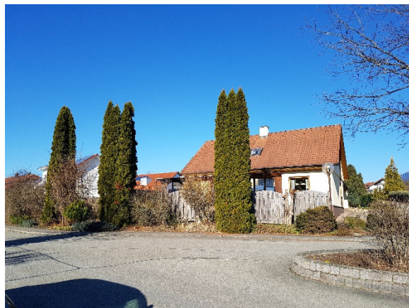
Blick nach Nordwesten auf die südliche Fassade des Gebäudes (Nr. 44)
