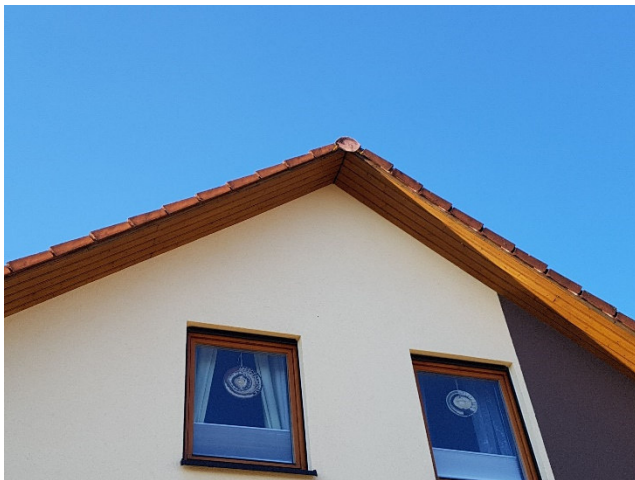
Foto 5: Wohnhaus – Nordost-Giebel mit Dachansatz
