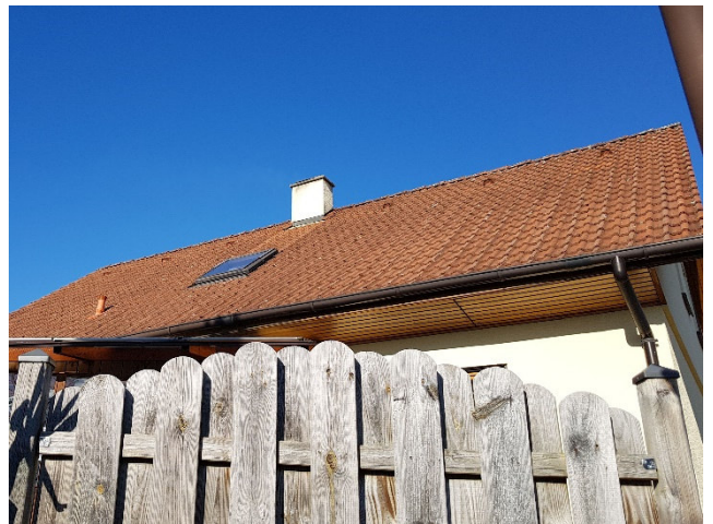
Foto 6: Wohnhaus – Dachansicht, Südost
