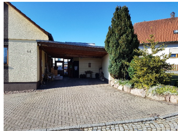
Blick nach Westen auf den Eingang zur bestehenden Garage von dem asphaltierten Weg (Flst. Nr 400/22)
