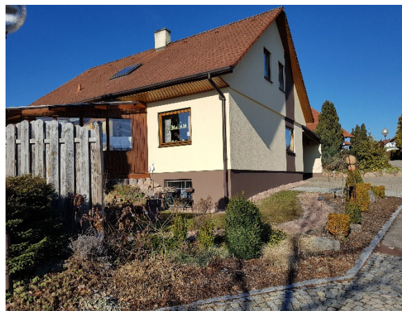
Blick nach Osten auf das Gebäude (Nr. 44)
