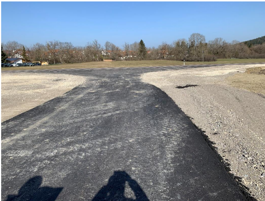
Foto: Provisorische Anbindung des Baugebietes „Grund“ an die K 7170
